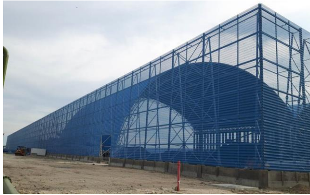
Hình 3. Tường chắn gió kho than hồ.
