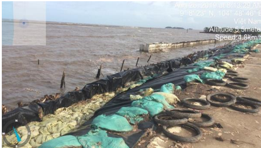
Hình 3. Khu vực bị sạt lở tại tuyến đê biển Hòn Đá Bạc–Kênh Mới không có rừng ngập mặn phía ngoài chắn sóng.
